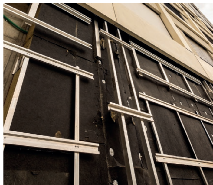
Bilder unten: Die Ebene der horizontalen Tragprofile für GFB- und Putzträger-elemente bildet die Aussenkontur der Fassade nicht aus. Diese entsteht erst mit dem Einhängen von Adapter-Stücken und der Elemente selbst.
